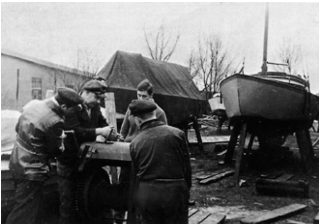
Gemeinschaftsdienst- Winde reparieren in den 50er Jahren
