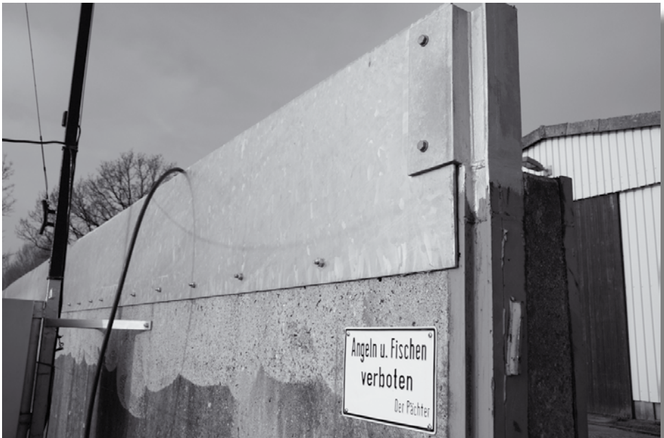
Hochwasserschutzwand ESV-seitig- erbaut mit einem Blech. SCOeseitig wird voraussichtlich ab 15. April 2013 eine neue Spundwand gerammt. Die Durchfahrt zur Slippbahn wird halbiert
